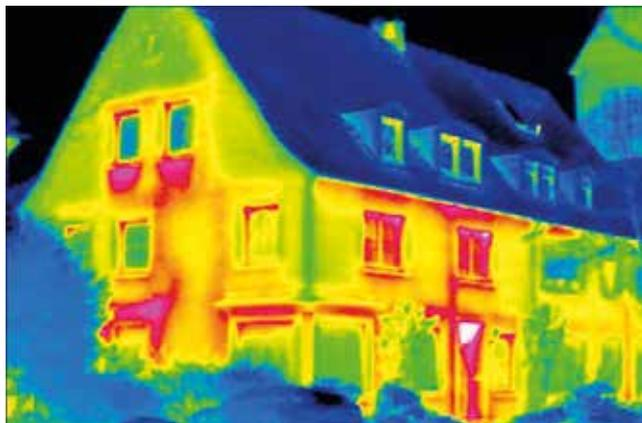
Die Thermografie ist ein Verfahren der Infrarot-Strahlungstemperatur-Messung. Mit Hilfe einer Wärmebildkamera wird Ihr Haus von außen durchleuchtet. Stellen Sie sich die Thermografie als eine Art Röntgen-
